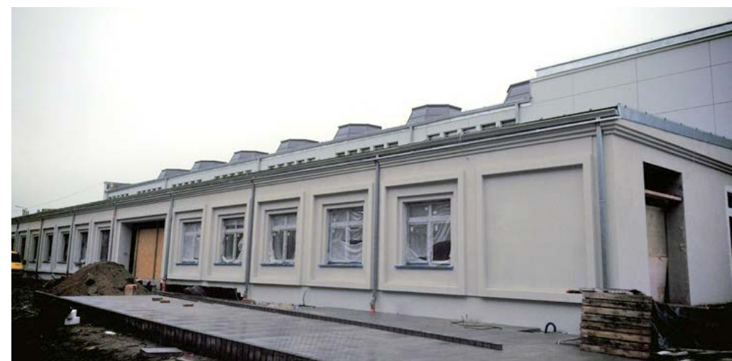
▶ Muzeum Centralnego Okręgu Przemysłowego w budowie, stan: listopad 2020 r., fot. W. Chudzik.
