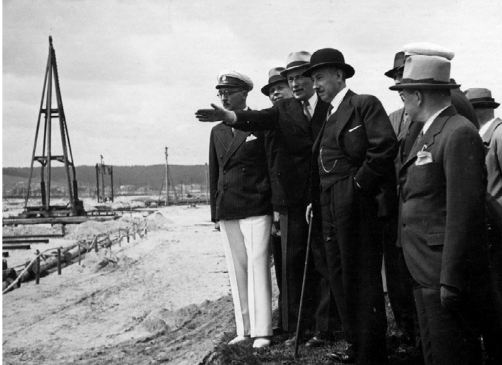
▲ Eugeniusz Kwiatkowski z delegacją rządową na placu budowy portu w Gdyni (lata 30-te XX w.).
