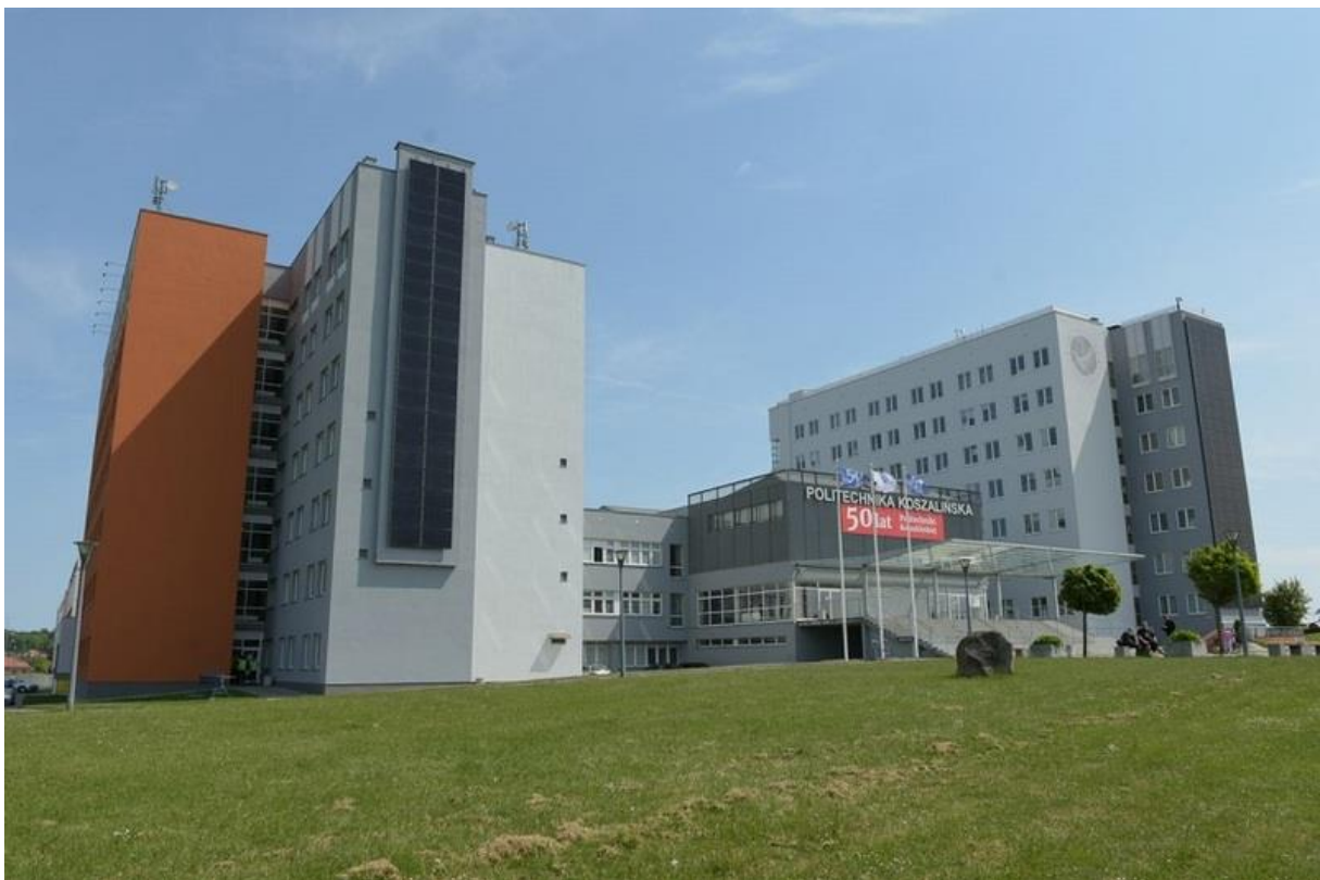
Stan robót budowlanych na dzień 23.05.2018 r.
